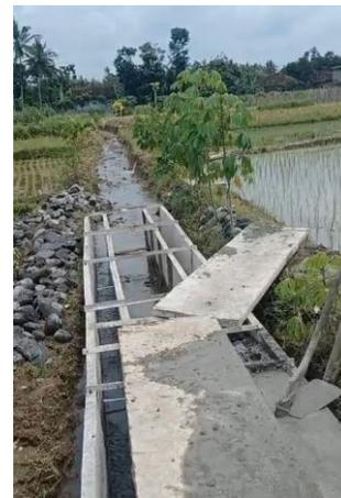
Gambar 2: Dokumentasi Pembangunan Saluran Irigasi yang Masih Dalam Proses.
